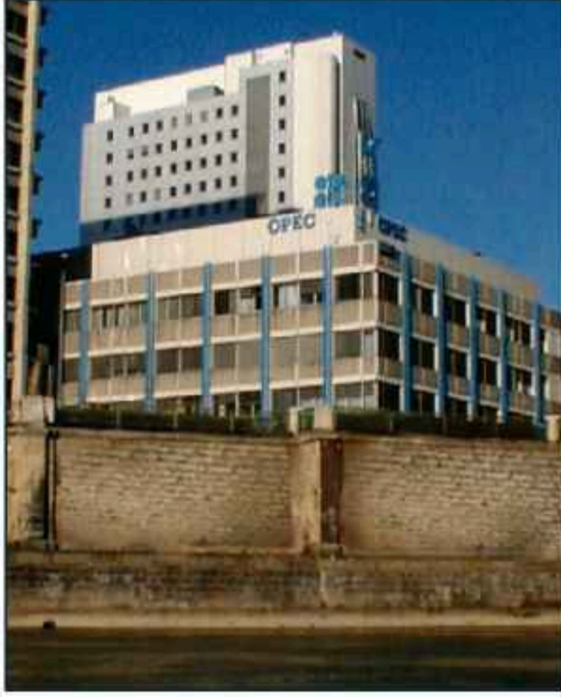
▲ مبنى منظمة أوبك في فيينا
